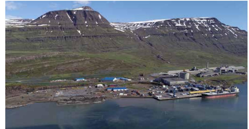
The Port of Mjóeyri. Photo: Fjarðabyggð
